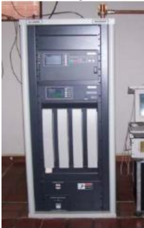
Figura 1. Transmisor marca Harris modelo Ranger estándar ATSC.
