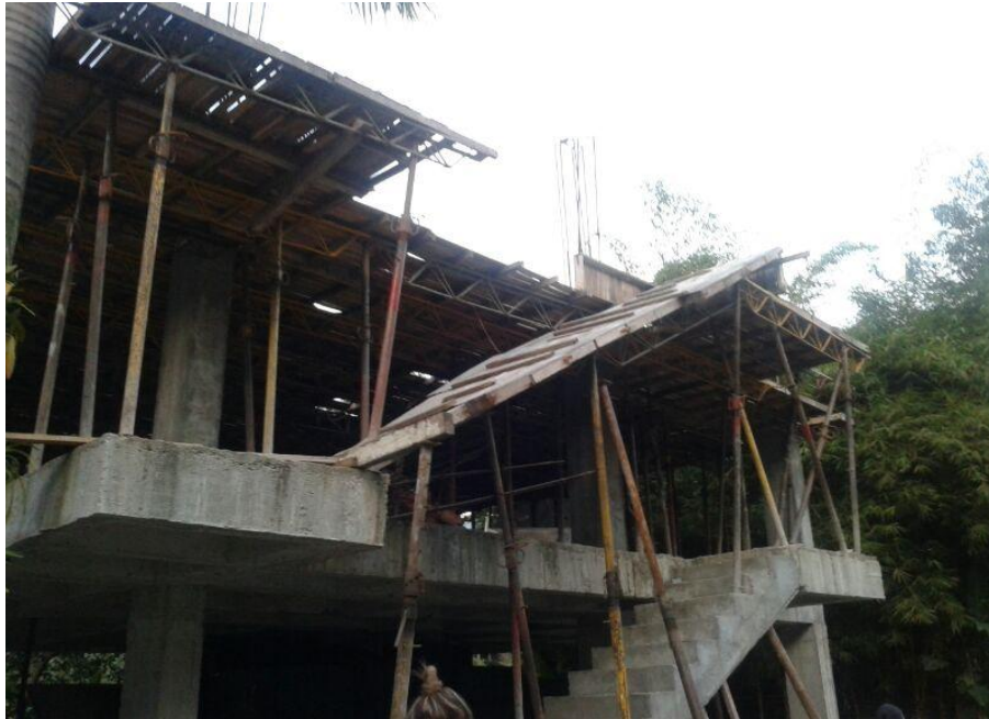
Figura 6. Fotografía construcción tercera planta de la Corporación Elena y Juan Elaborada por: grupo de investigación
