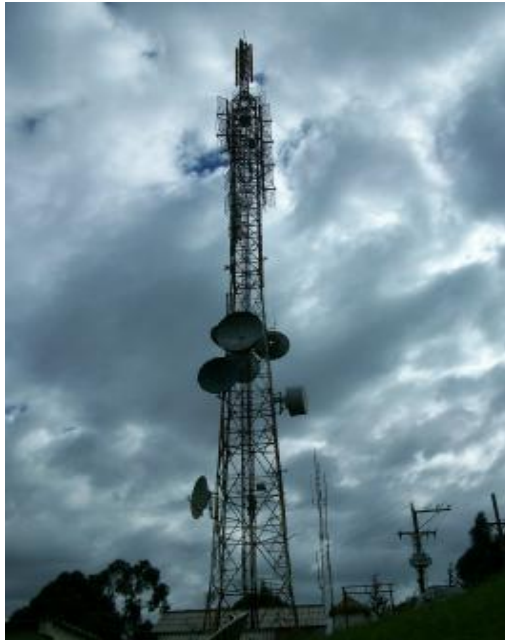
Figura 24. Vista de la estación de Calatrava.
