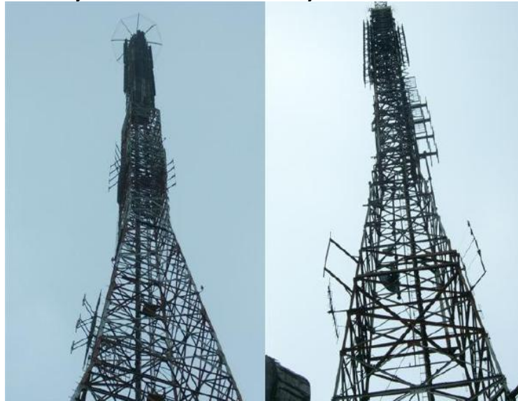
Figura 25. Vista torres 1 y 2 en la estación de Manjuí.
