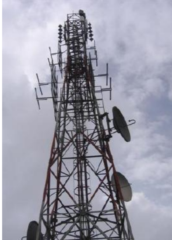
Figura 26. Vista de la estación de Boquerón de Chipaque.
