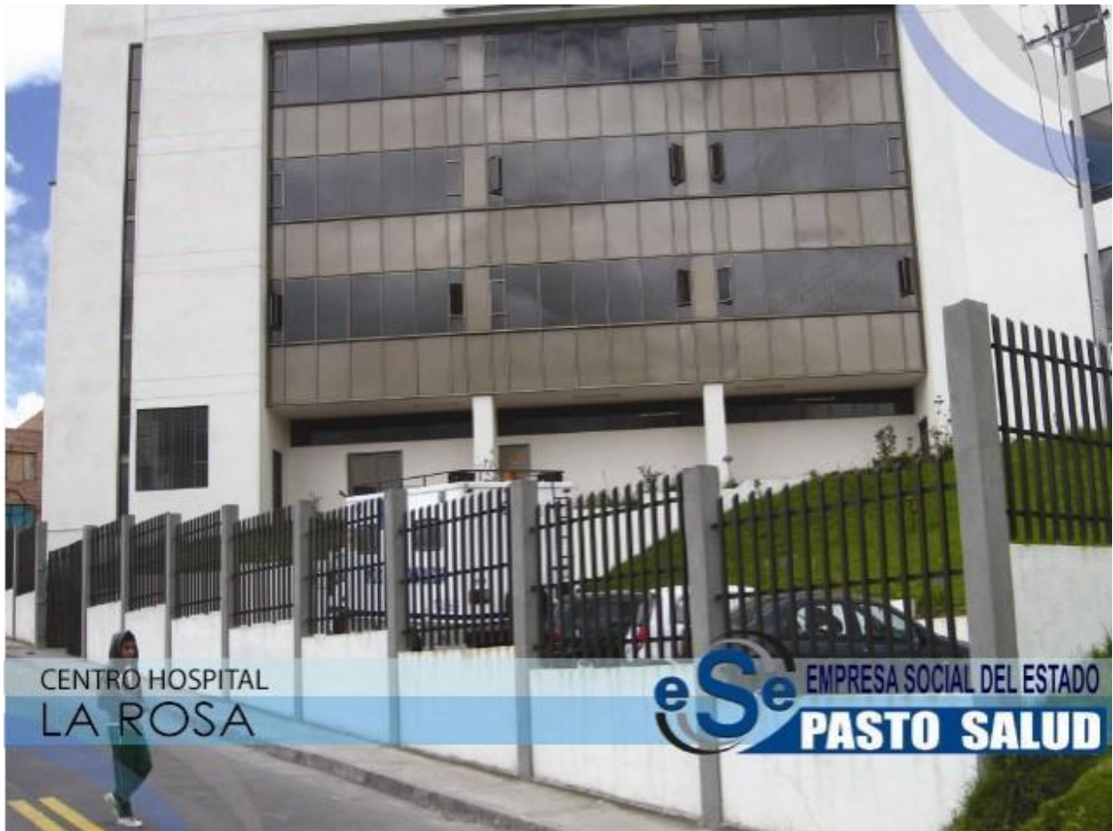
Figura 1. Centro Hospital La Rosa. Fuentes: Google maps y google. 2016
