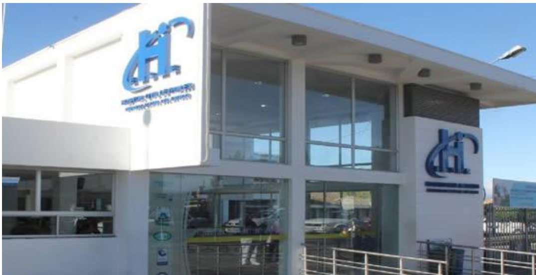
Figura 2. Institución de salud Hospital Civil de Ipiales
