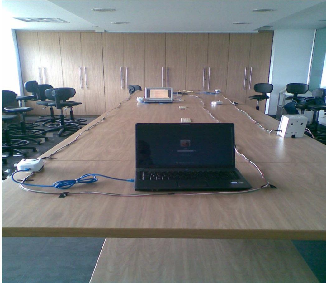
Figura 44. DHP-300 sobre red eléctrica menor a 100 mts.
