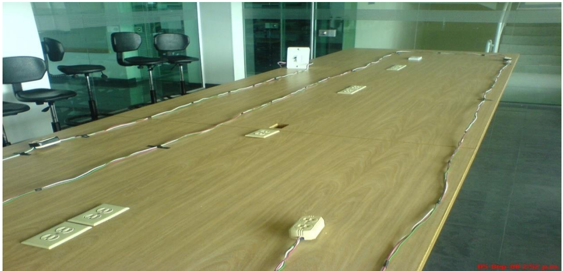
Figura 21. Instalación eléctrica construida.
