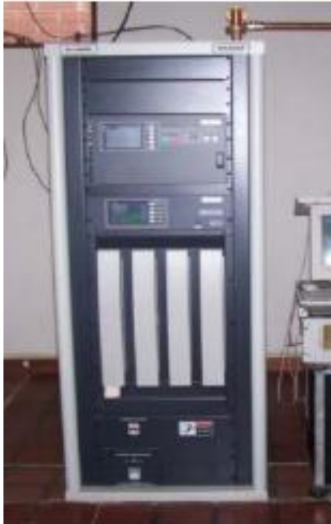
Figura 1. Transmisor marca Harris modelo Ranger estándar ATSC.
